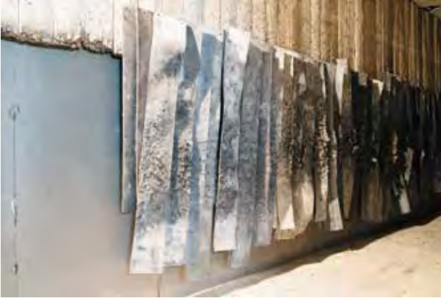
Espai posterior a la paret de la Sala de tir amb diverses bales a terra.
